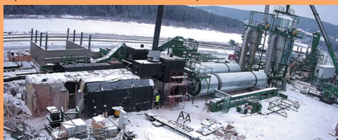
Общий вид завода на ТСПК
